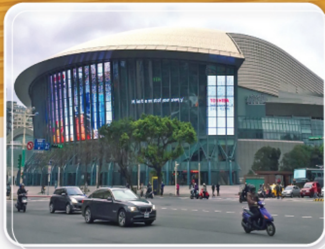
▲ 工程名稱：台北小巨蛋 工程項目：複層結構屋頂金屬板
