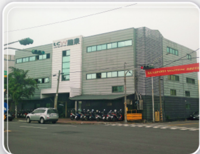
▲ 工程名稱：龍泉科技有限公司 工程項目：鋼骨結構 / 屋頂金屬板 / 牆面金屬裝潢板
