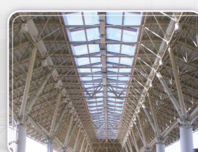
▲ 工程名稱：高雄橋頭捷運站 工程項目：金屬空間桁架
