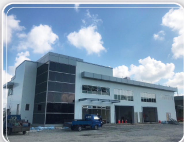
▲ 工程名稱：自駕車試驗場 工程項目：鋁包板 / 防火時效屋頂金屬板 / 防火時效牆面金屬三明治板
