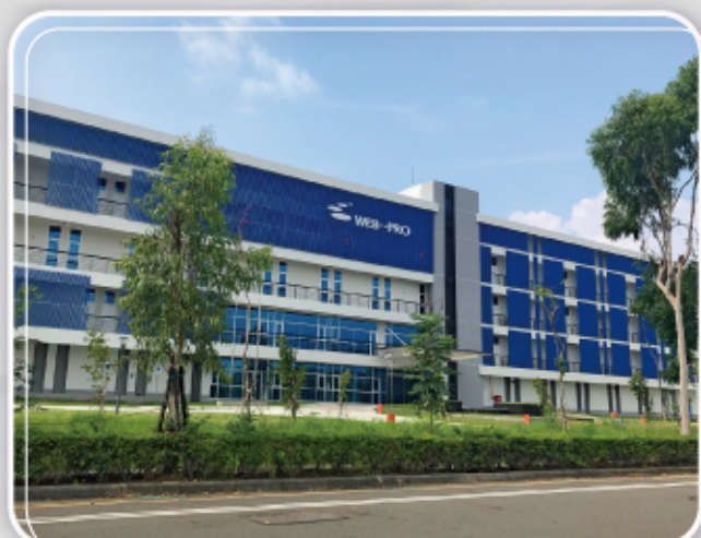
▲ 工程名稱：衛普實業股份有限公司 工程項目：防火時效A型鋼屋頂金屬板系統 / 牆面金屬三明治板
