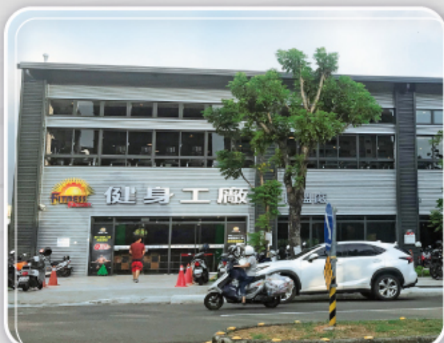
▲ 工程名稱：健身工廠同盟廠 工程項目：防火時效屋頂金屬板 / 防火時效外牆金屬板
