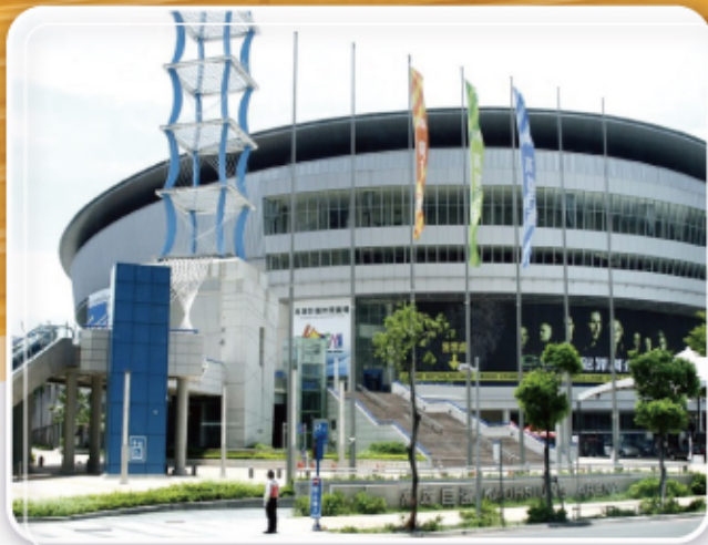
▲ 工程名稱：高雄巨蛋 工程項目：外牆骨架 / 外牆金屬板
