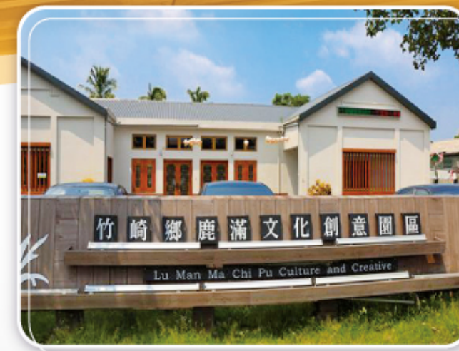
▲ 工程名稱：鹿滿文化園區 工程項目：防火時效A型鋼屋頂金屬板系統
